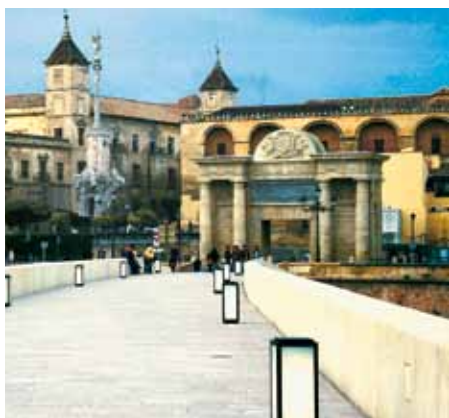
Puente romano restaurado con la Puerta del Puente Restored Roman Bridge with the Puerta del Puente
